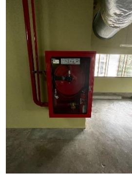
ตู้สายฉีดน้ำดับเพลิงพร้อมอุปกรณ์
