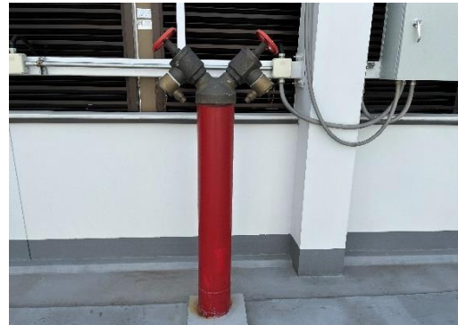
หัวจ่ายน้ำดับเพลิงชั้นดาดฟ้า
